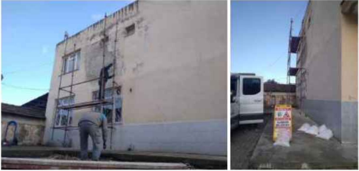
İlgın Mahallesi Muhtarlık Binası Bakım Onarım Çalışmaları Yapıldı.
