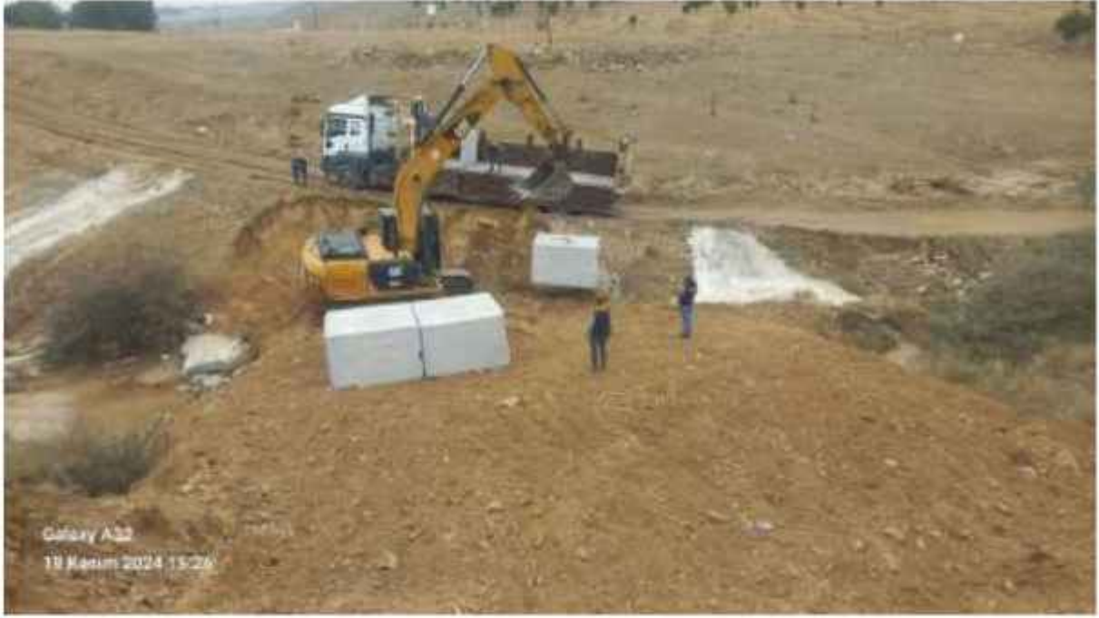
Örnekköy Mahallesi Kırsal Sulama Borusu Döşendi.
