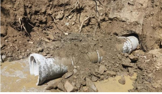
Bahçedere mahallesi merfez çalışması
