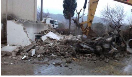
Kavaklıdere mah düğün salonunun eski tuvaletler yıkılması
