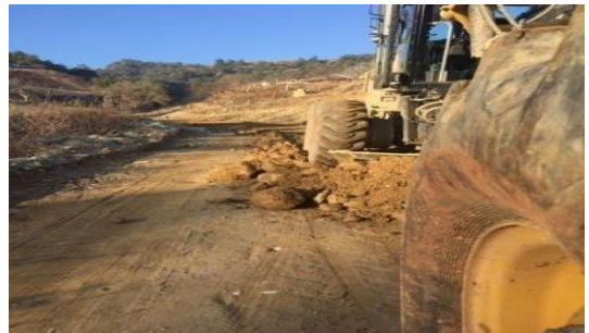
Çeşneli Mahallesi Yol Çalışması
