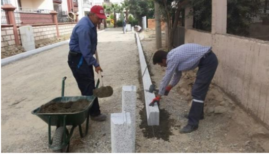
Kurtuluş mahallesinde bordur çalışması
