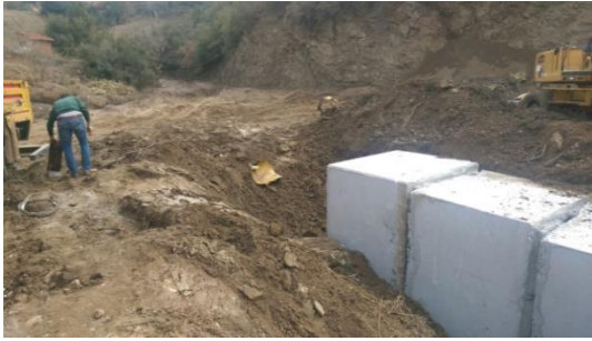
Çarıkbozdağ mahallesi gürlek mevkii menfez yerleştirme çalışması
