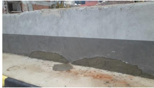
Sehit Fevzi cad. no 35 zarar gören duvarın sıva işi yapıldı.
