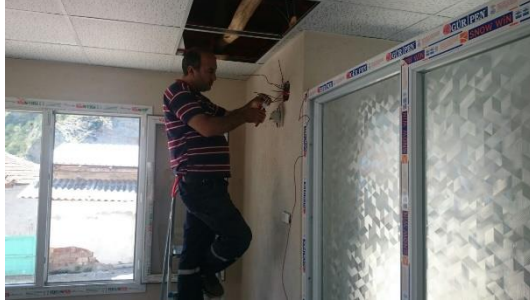
Göbekli Mah. muhtarlık binası elektrik tesisatı yapıldı
