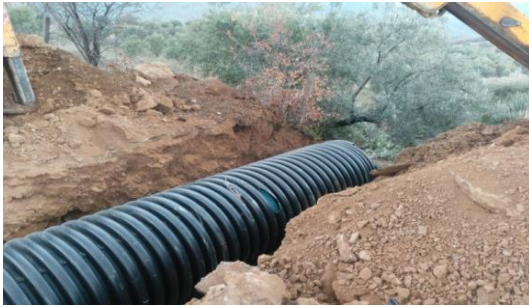
Horzum alayaka mah.i dere suyu tahliyesi için yola korge boru yatırıldı.
