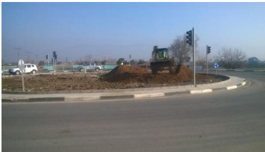
Yeni Mahalle Hastane Kavşağı Dolgu
