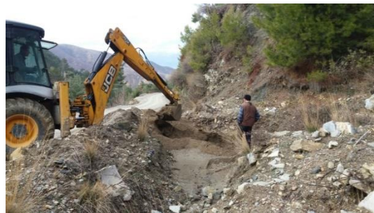
Çamlıbel mahallesi yol ve şarmpol açma çalışması
