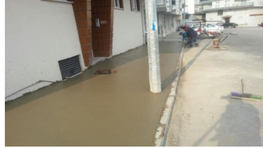
Kurtuluş mahallesi zeytinli sokakta kaldırım betonu atımı
