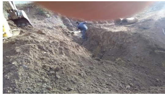
Kozluca Mah korige boru döşenmesi
