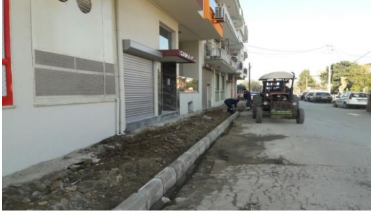
Hacıbey mahallesi bordür yapımı
