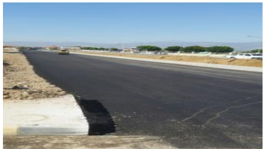
Hastane Acil Girişi Sıcak Asfalt Çalışması
