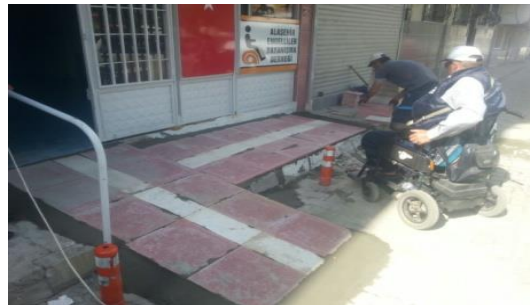
Engelliler Derneği önü rampa yapımı
