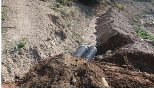
Osmaniye Mah. Yol çalışması ve Korige boru yatırılması
