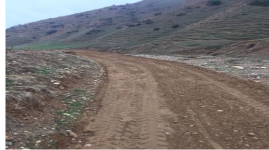
Alhan Mahallesi Yol Çalışması
