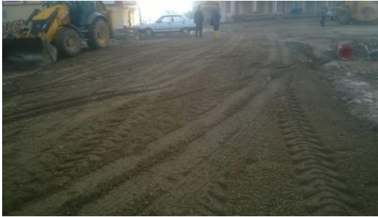
İstasyon Mahallesi Yol İyileştirme
