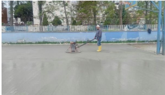
Atatürk ilköğretim okulunda beton atımı
