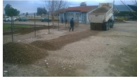
Stadyum soyunma odası önünü micirlama
