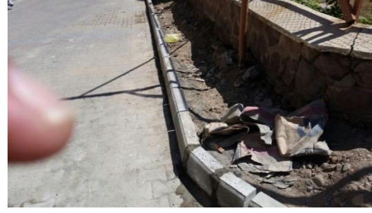
Soğuksu mahallesi kilise önü bordur çalışması
