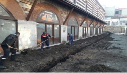
Kurşunlu hanında yağmur suyu tahliye hattı yapımı
