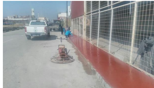
Yeni mahalle labella otel karşısında kaldırım betonu atımı
