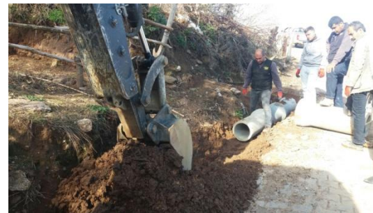
Horzumsazdere mah. yağmur suyu hattı büz döşenmesi
