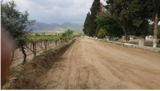
Yeşilyurt Mahallesi yol çalışması
