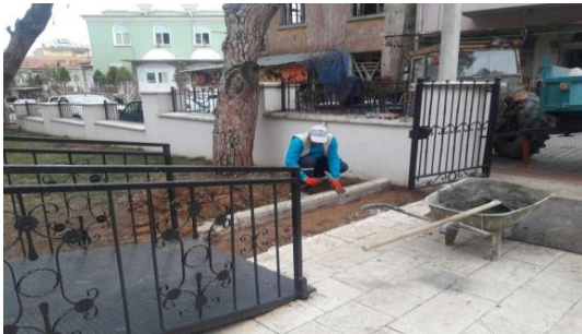
Kütüphane özürlü rampa yapımı
