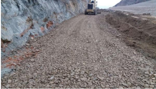
Çöplük Yolu Dolgu Çalışması
