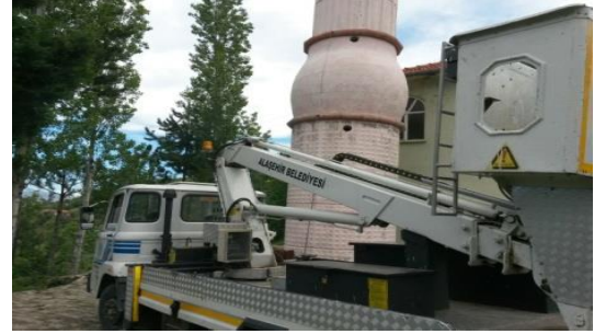
Uluderbent Çamlıbel Mah. camii hoparlör montajı
