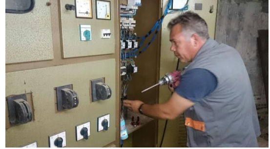
Yüzme havuzu elektrik tadilatı yapıldı
