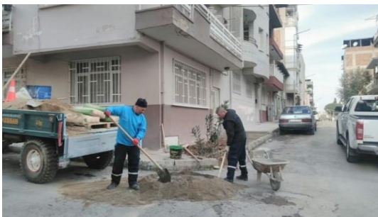
İsmetpaşa caddesi bordür çalışması
