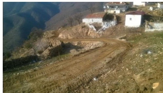
Serinyayla mahallesi yol iyileştirme ve şarmpol açma çalışması
