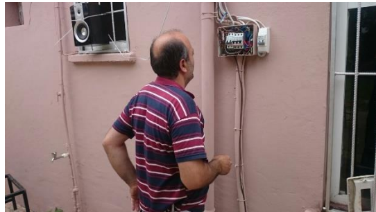
Girelli Mah. sağlık ocağı elektrik tesisatı yapıldı
