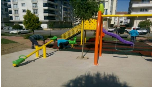
Kurtuluş mah.zeytinli sokak parkta kauçuk döşeme çalışması
