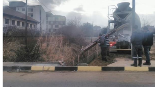
İstasyon Akkeçili Caddesi Kanal Betonlu
