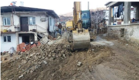
Dağhacıyusuf yol çalışması
