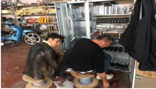
Yeni belediye binası ana pano hazırlanması
