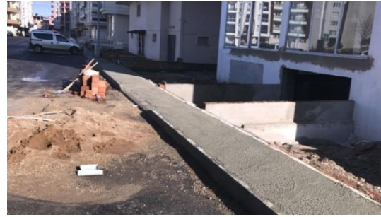
Kurtuluş mah zeytinli sokak kaldırım betonu
