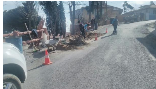
Toptepe çıkışındaki kaldırım düzenlemesi ve beton atımı
