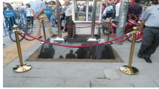
Yeni Belediye Binası Önü Bayrak Direği Montajı
