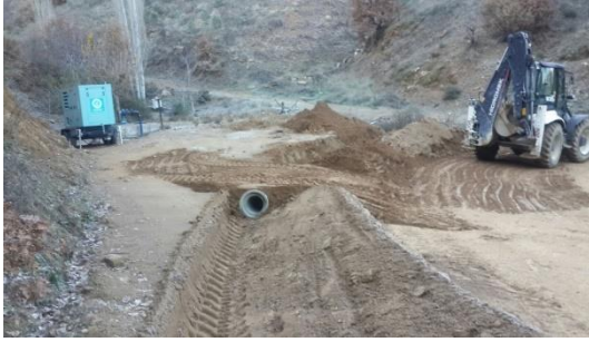
Dağarlar mah. büz döşenmesi
