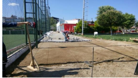
Bariş Manço parkında kilit parke taşı döşeme
